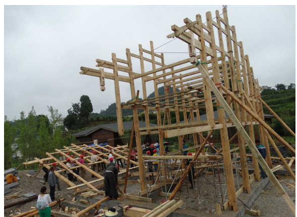
Levage collectif de la charpente
